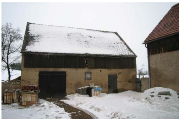
Abbildung 23: Beispielprojekt HF A: Umbau eines Stallgebäudes zu Wohnzwecken in Bornitz
