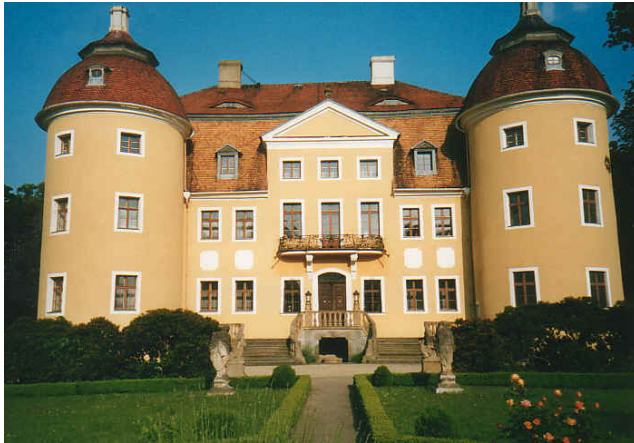
Abbildung 32: Beispielprojekt HF C: Dachsanierung Schloss Milkel
